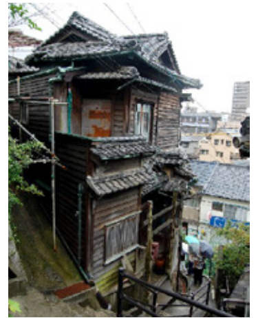
空き家再生プロジェクトの象徴的建造物「ガウディハウス」
