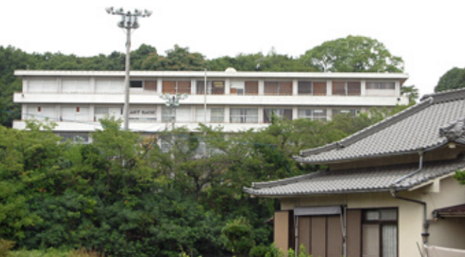
中学校の旧校舎を改装した「ART BASE 百島」。島の高台に位置する
